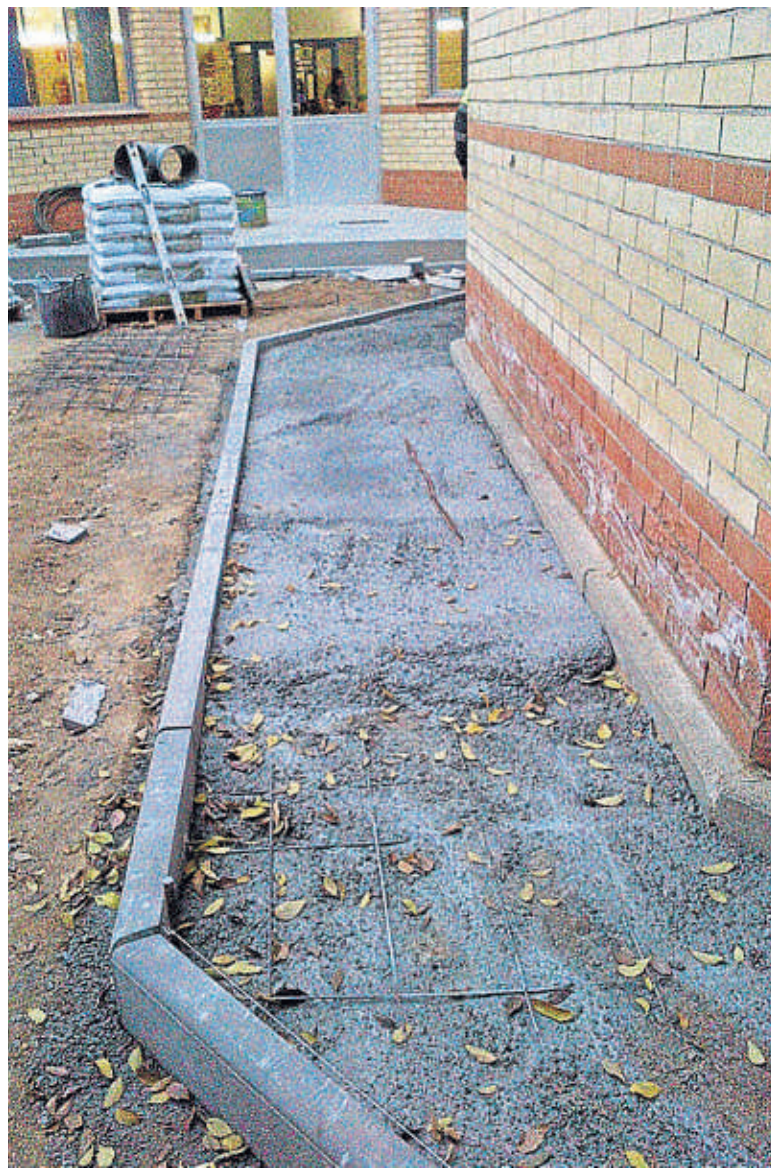
CONSTRUCCIÓN DE UNA ACERA PARA AISLAR HUMEDADES DE LA ESCUELA PROVENÇALS
