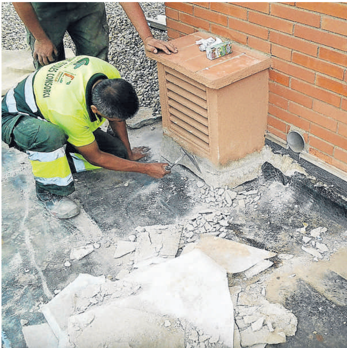
UN OPERARIO ARREGLA LAS GOTERAS DE LA ESCUELA PAU VILA, EN EL BARRIO FONT DE LA GUATLLA, EN EL DISTRITO DE SANTS-MONTJUÏC
