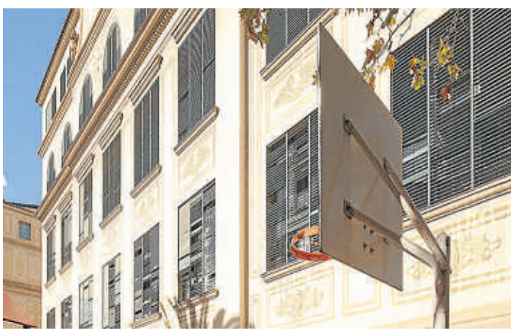
ESTE AÑO SE INICIA LA REHABILITACIÓN DEL EDIFICIO DEL RAMON LLULL. F. CAMALLONGA
